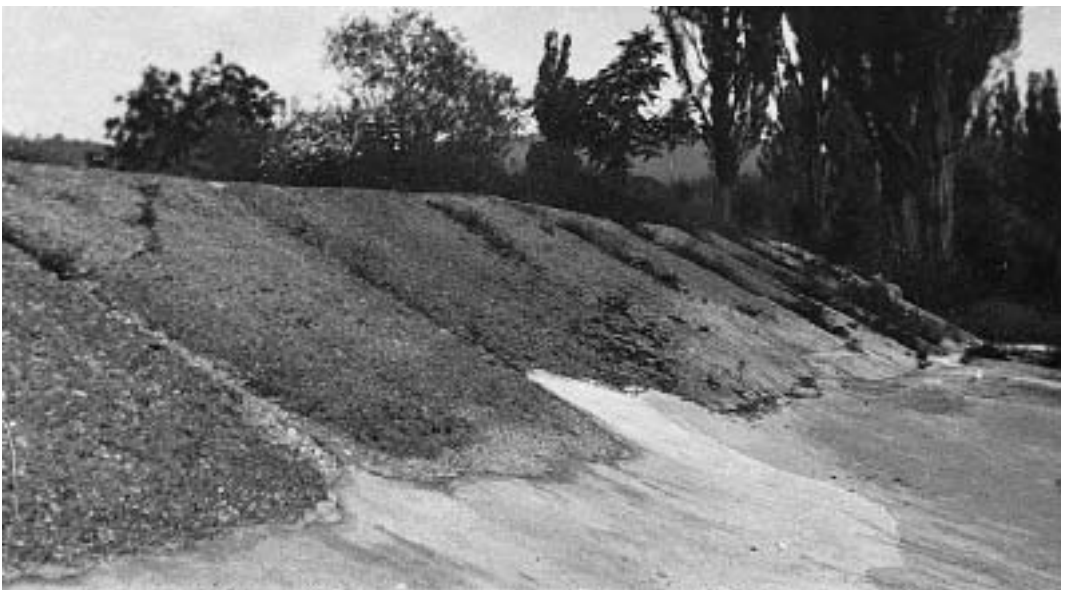
Abb. 32: Dornachbrugg um 1900. Neu geschütteter Damm kurz nach der Korrektur. Der Damm ist im unteren Teil mit einer Pflasterschicht befestigt, im oberen humusiert und noch kaum bewachsen (im Projekt war eine Begrasung vorgesehen). Die Humusierung ist vom Regen z.T. wieder wegerodiert. Auf solchen Dämmen, wie sie um die Jahrhundertwende zahlreich entstanden, konnten sich grossflächig Ruderalgesellschaften ausbreiten.
