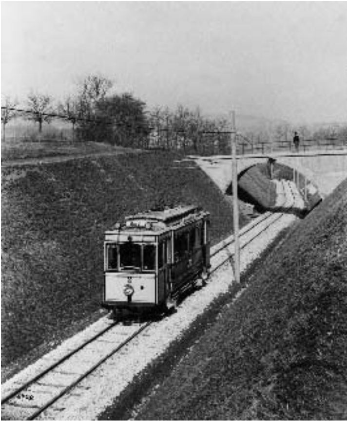
Abb. 40: Die 1902 erbaute Tramlinie nach Arlesheim bei Hofmatt, um 1920. Die Linie steigt zuerst in einem natürlichen Graben, dann in einem künstlichen Einschnitt in der Niederterrasse auf. Die steilen Dämme wurden nach der Abgrabung mit (magerem Humus) bedeckt und begrast. Auf dem Bild sind sie sorgsam gemäht, an den Dammoberkanten sind Erdanrisse, Lebensraum trockenheitsliebender Vegetation (Mauerpfefferfluren), erkennbar.
