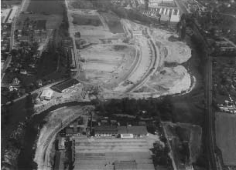
Abb. 39: Birskorrektur von 1971 nördlich der Metallwerke (Luftaufnahme). Die Birs wird in ein neues begradigtes Bett verlegt. Man versuchte mit einer landschaftsarchitektonischen Begleitplanung das Projekt einigermaßen naturverträglich zu gestalten. «Nach Fertigstellung des Bauwerkes ging es darum, die harten technischen Zäsuren zu mildern und durch gezielte grünplanerische Mittel wieder einen naturnahen Landschaftsraum aufzubauen...» (Wiede 1974).
