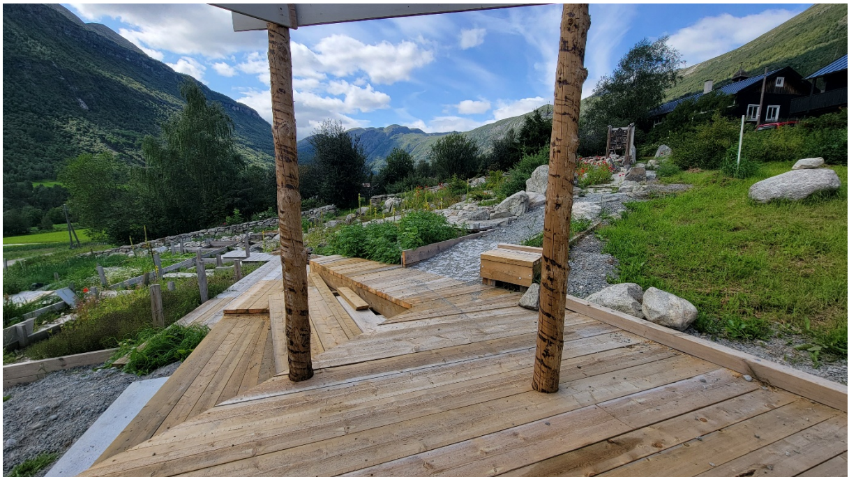
... und Landschaftstempel im Bau!
